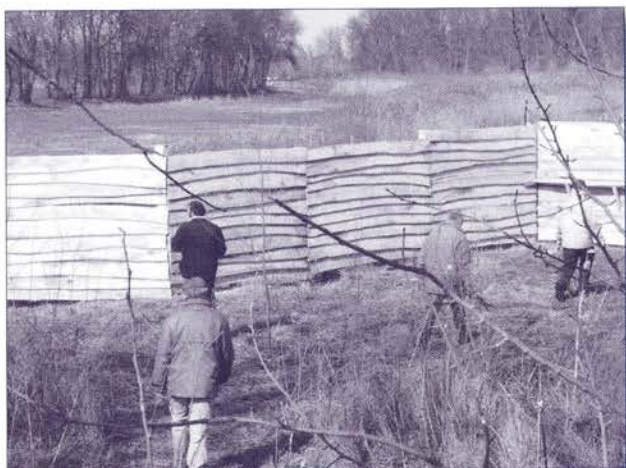
De vogelobservatiewand wordt geplaatst
